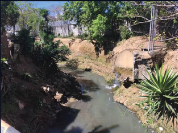
Degradación de las riberas del río. Sitio 16. Cercano Colegio Franco.
